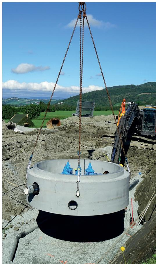
Basal Aqua-Safe er bransjens sikreste vannkum. En vannkum som leveres komplett, direkte på grøftekanten og følger kravene i VA-miljøblad nr. 112. Basal Aqua Safe monteres innomhus i rene lokaler, av sertifiserte montører med spesialkompetanse. Basal Aqua Safe er en vannkum dimensjonert for opptrædende krefter, har 100 års levetid og er samtidig 100% sikker.
